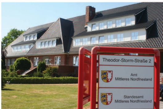
Das Amtsgebäude in der Theodor-Storm-Straße
