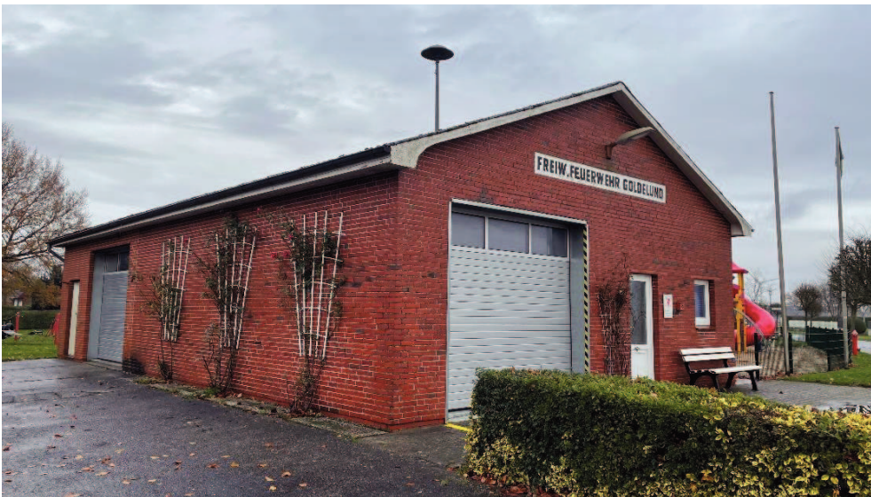
Abbildung 8: Feuerwehrgerätehaus der Gemeinde Goldelund
